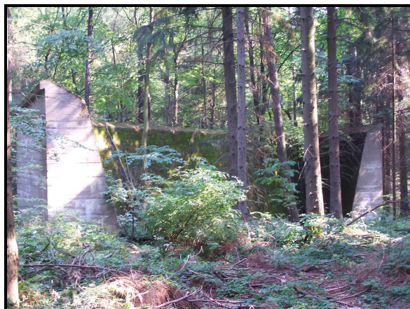
Opěra pro chystanou dálnici
