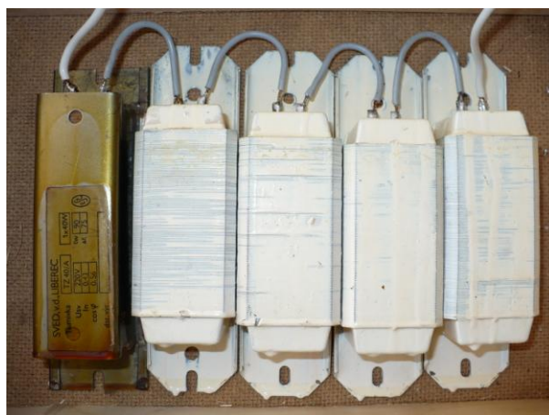
Obr. 34: sériově propojené tlumivky
