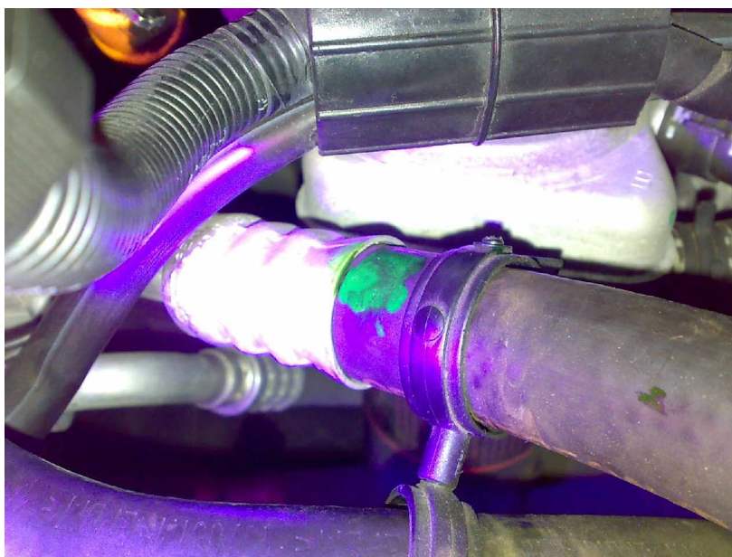
Obrázek č. 14 Zkouška pomocí UV lampy
