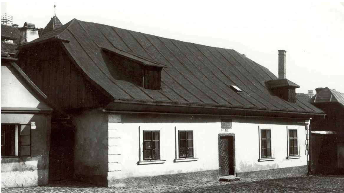
Příloha 27 - historické snímky – nahoře č.p.62, dole pohled na jihovýchodní část
