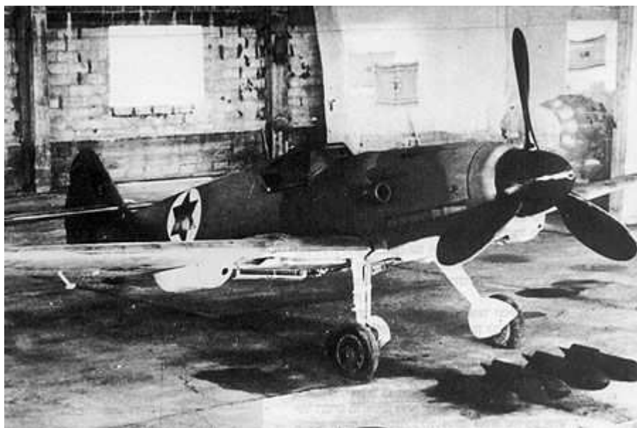
obr. 29. – „Mezek“, nevhodný motor Jumo s velkou vrtulí dominuje draku letadla
